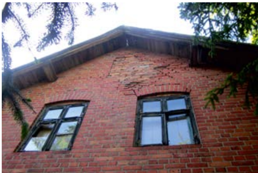
Szczyt domu Moniki Pompeckiej ze śladami uszkodzeń powstałych w wyniku wybuchu pocisku
