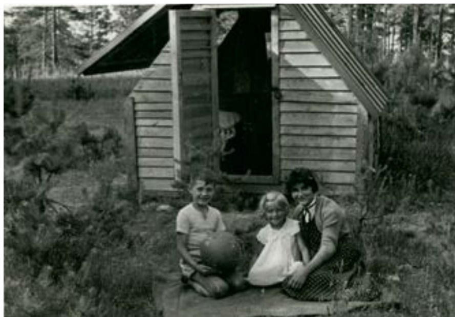
Dzieci przy domku z uchylanym dachem
